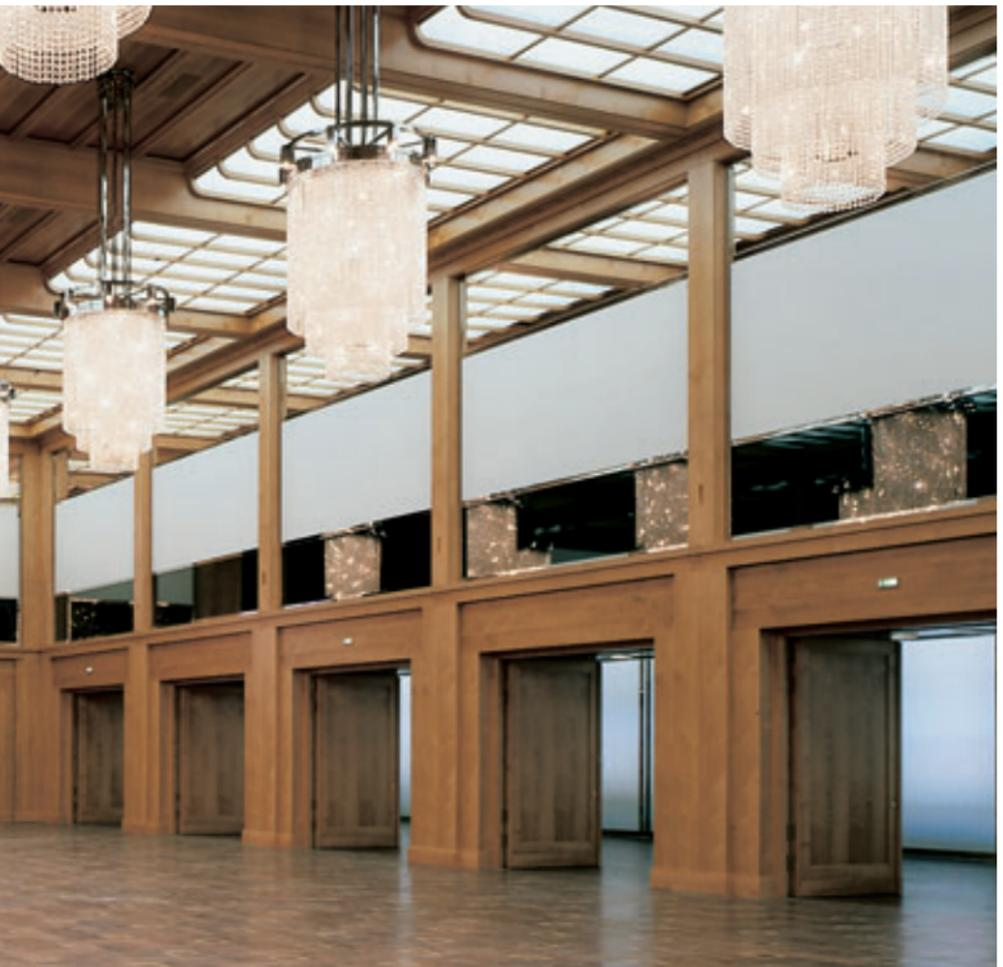
Diese Spiegelfläche bietet eine optische Vergrößerung der Lichtdecke, an der die ungewöhnliche Modernität der Ersten Schicht des Gebäudes sichtbar wird. Durch eine moderne Tragwerkkonstruktion aus Stahl, auf der die drei schmaleren Geschosse über dem Saal aufrufen, war es möglich, seitlich an diesen Etagen vorbei Tageslicht in die Halle fallen zu lassen.
