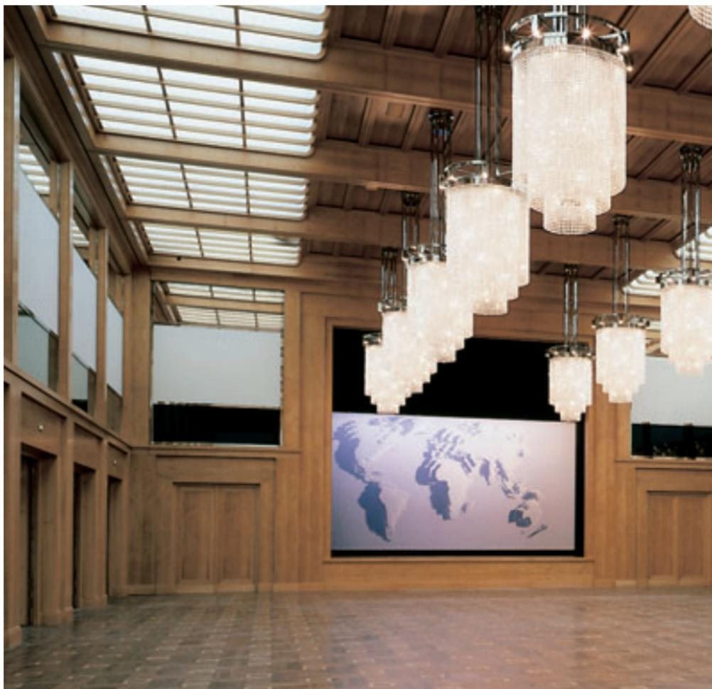
Der untere Teil der Wandflächen mit den Türen zu den Lounges ist mit Paneelen verkleidet, die mit deutschem Kirschholz furniert sind. Darüber liegen die Arbeitsplätze der Dolmetscher, die durch eine Blende gegen den Saal abgeschirmt werden. Diese Blende ist horizontal in drei monochrome Felder geteilt, die jeweils durch einem schmalen Aluminiumrahmen gefasst sind. Das untere Feld besteht aus schwarzem Glas, das größere Mittelfeld aus weißer Leinwand und das obere Feld ist ein Spiegel.
