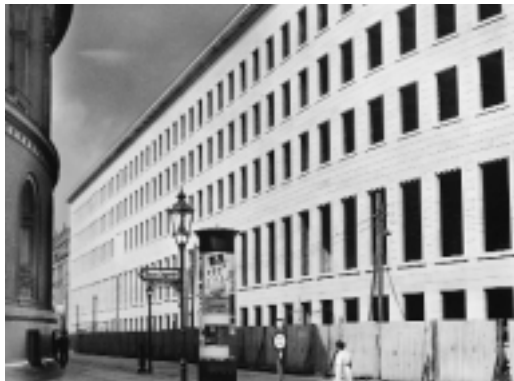
Der Erweiterungsbau im Rohbau. Fassade an der Kurstrasse, 1937 Shell of the extension. Kurstrasse façade (1937) Le gros œuvre du nouveau bâtiment, façade côté Kurstrasse, 1937
