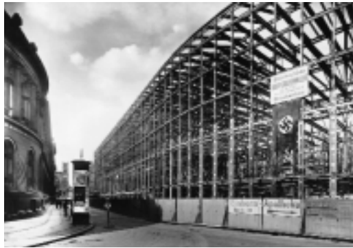
Das Stahlskelett des Erweiterungsbau an der Kurstrasse, 1936 Steel structure of the extension in Kurstrasse (1936) L'ossature métallique du nouveau bâtiment dans la Kurstrasse en 1936
