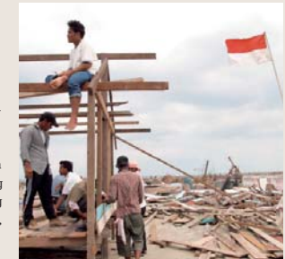
Wiederaufbau einer durch den Tsunami zerstörten Moschee in Indonesien
